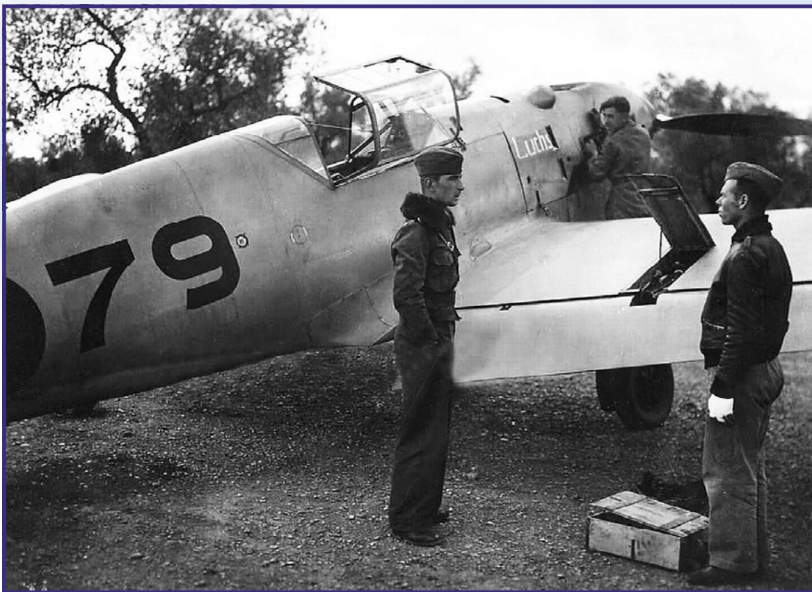
Werner Mölders podává hlášení po úspěšném letu. Jeho letoun Bf 109 D-1 má otevřené nábojové schránky křídelních kulometů.
