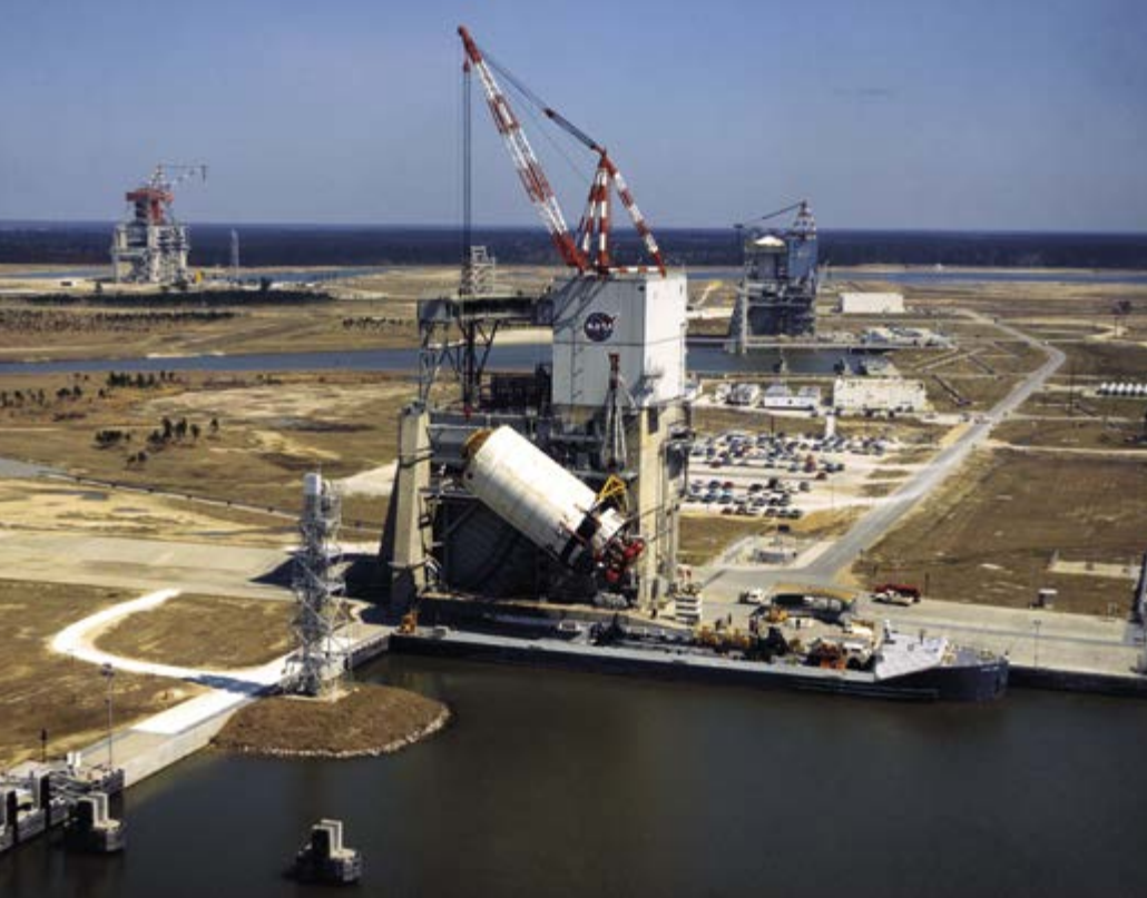
Príprava druhého stupňa Saturnu V S-II pred skúškami v Mississippi Test Facility (Dnes Stennisove stredisko NASA).
