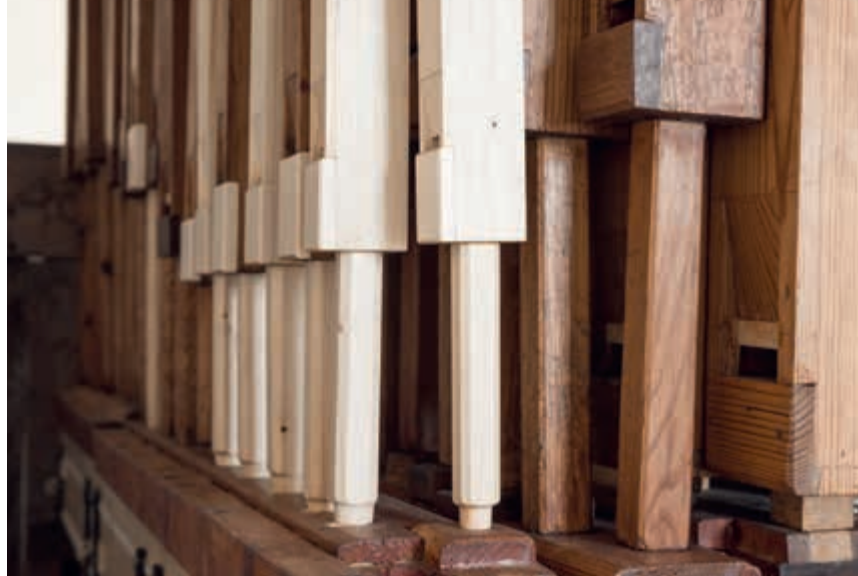
Dřevěné pedálové píšťaly stojící na pedálové vzdušnici
