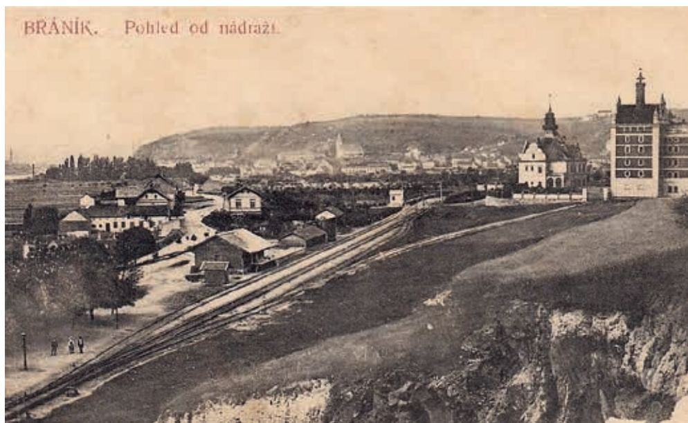
Dvě pohlednice s nádražím v Braníku od jihu. Na horním obrázku je původní stanice, tak, jak byla v roce 1882 postavena se dvěma kolejemi, v pozadí je pivovar založený v roce 1899. Na dolním obrázku jsou ve stanici již tři koleje a také nová vlečka do pivovaru, sbírka Josef Bosáček.
