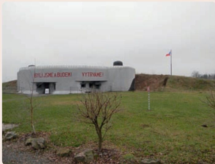
Pěchotní srub U cihelny
