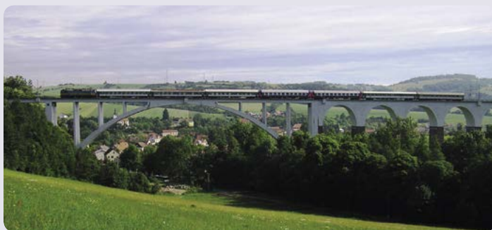
▲ Hned za prvním tunelem nad Tišnovem, sloužícím k válečné výrobě, se klene v Dolních Loučkách nad údolím železniční viadukt s jedním z největších evropských mostních oblouků železobetonové konstrukce o rozpětí hlavního oblouku 110 m. Jeho stavba začala v roce 1939, dokončen byl však až v 50. letech 20. století.
