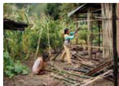
Stavba bambusového domu ve Vietnamu
