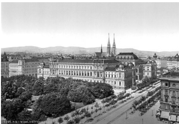
Ringstrasse před dokončením
